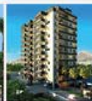
SANT TROPEZ CONDOMINIUM CLUB Barra D'Água
